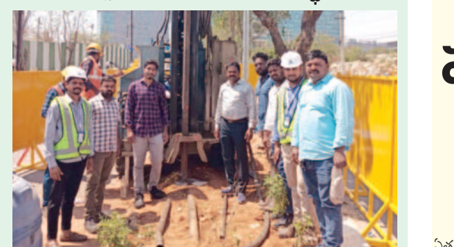
ఎయిర్పోర్టు మెట్రో పిల్లర్ నిర్మాణం కోసం భూసామర్థ్య పరీక్షలు నిర్వహిస్తున్న దృశ్యం
